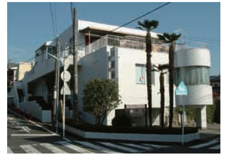
屋上・外壁の遮熱
