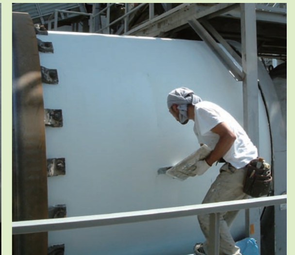
ドライヤーの外壁に
